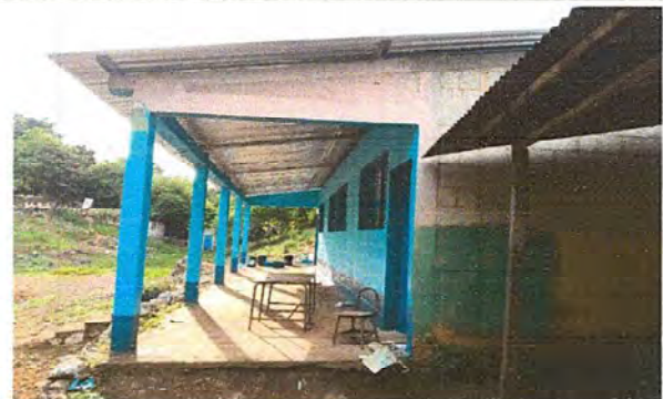
Foto 4: Inicio de pintura del módulo 1
