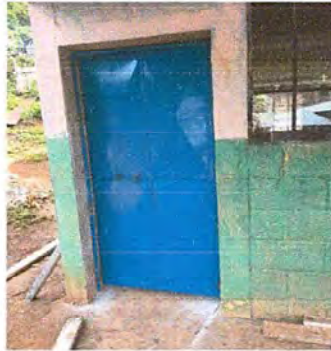
Foto 1: Cambio de puerta
