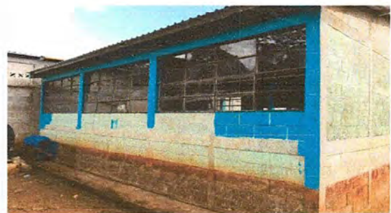
Foto 6: Inicio de pintura del módulo 2
