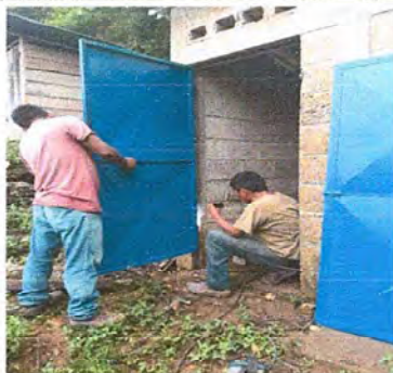
Foto 3: Cambio de puertas de letrina
